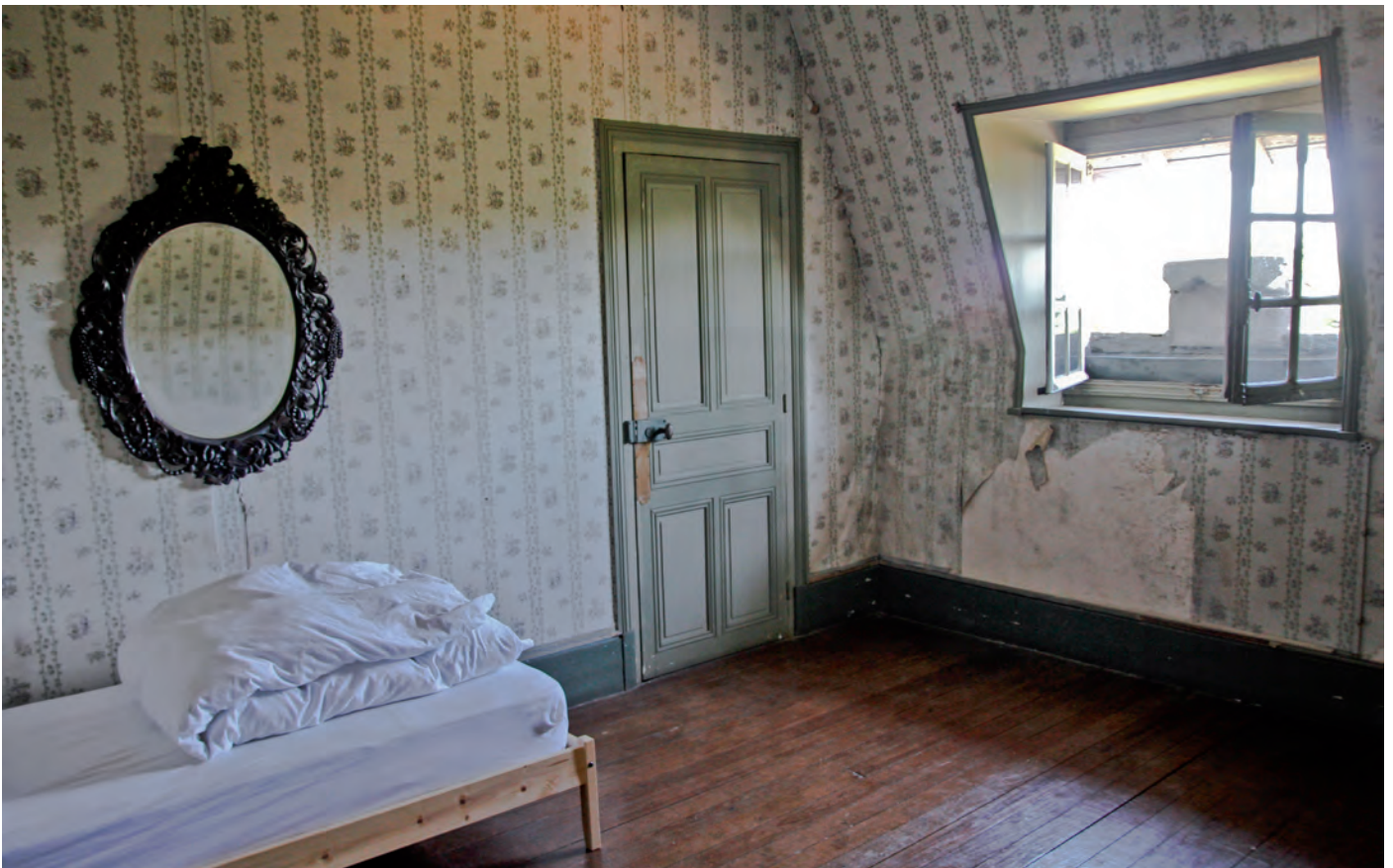
Dachschräge, Fenster und Verbindungstür
