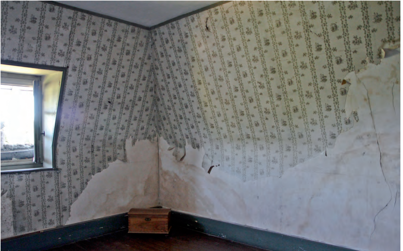
Zimmerecke mit beiden Dachschrägen
