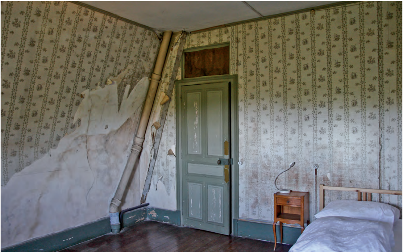
Tür zum Gang mit Oberlicht und Gussrohr
