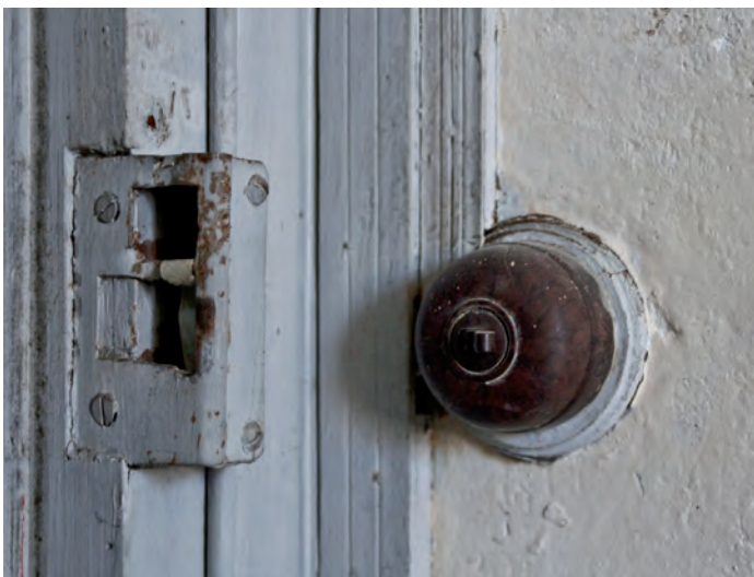
Detail alter Lichtschalter und Türklinke
